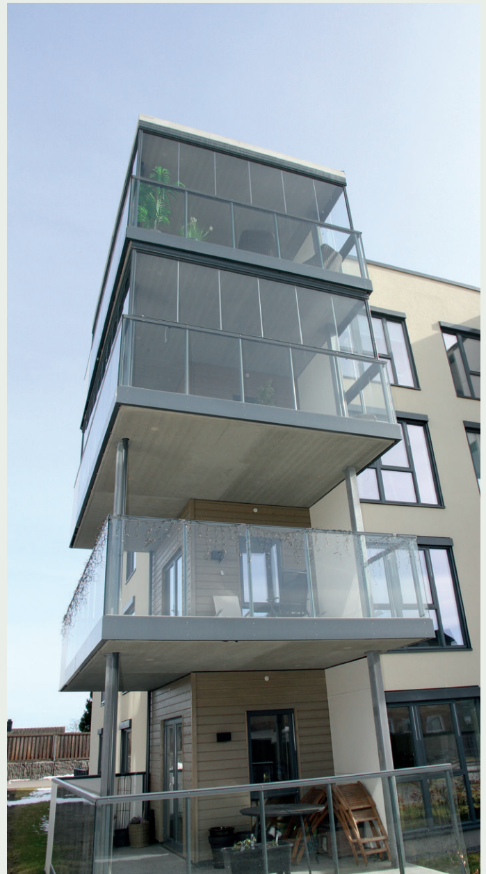
Utenpåhengte fasader med glassrekkverk.
